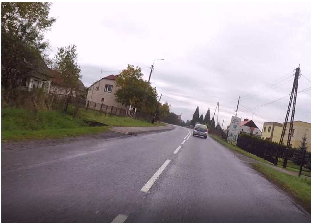
Fot.3 Początek chodnika dla pieszych wzdłuż ul. Turskiej w Mszanie
