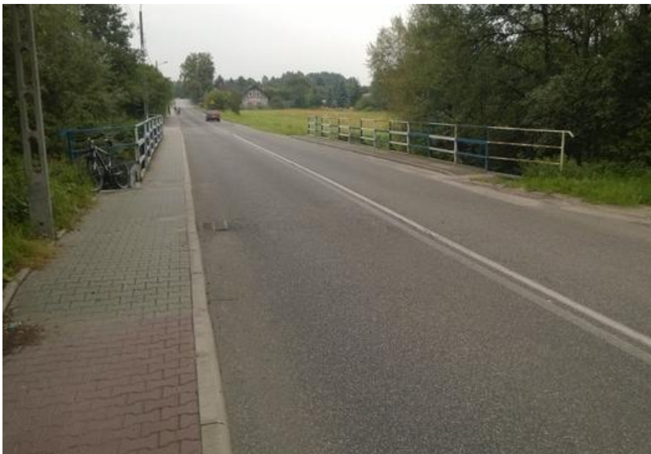
Fot. 2. Widok wiaduku od strony Gólkowic
