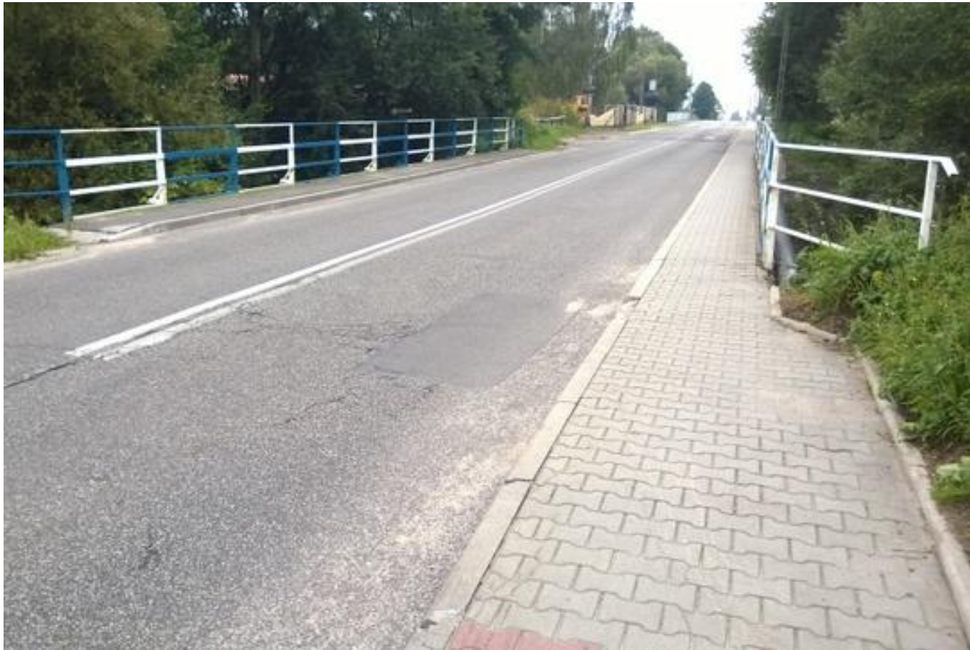
Fot. 1. Widok wiaduku od strony Wodzisławia Śl.
