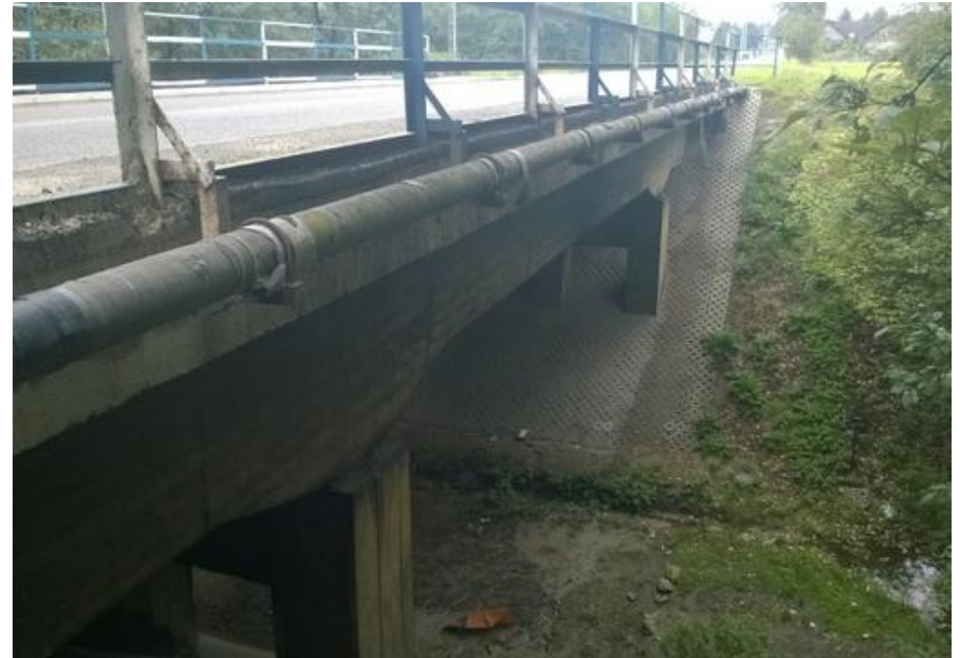
Fot. 3. Widok wzdłuż wiaduku od strony południowo-wschodniej
