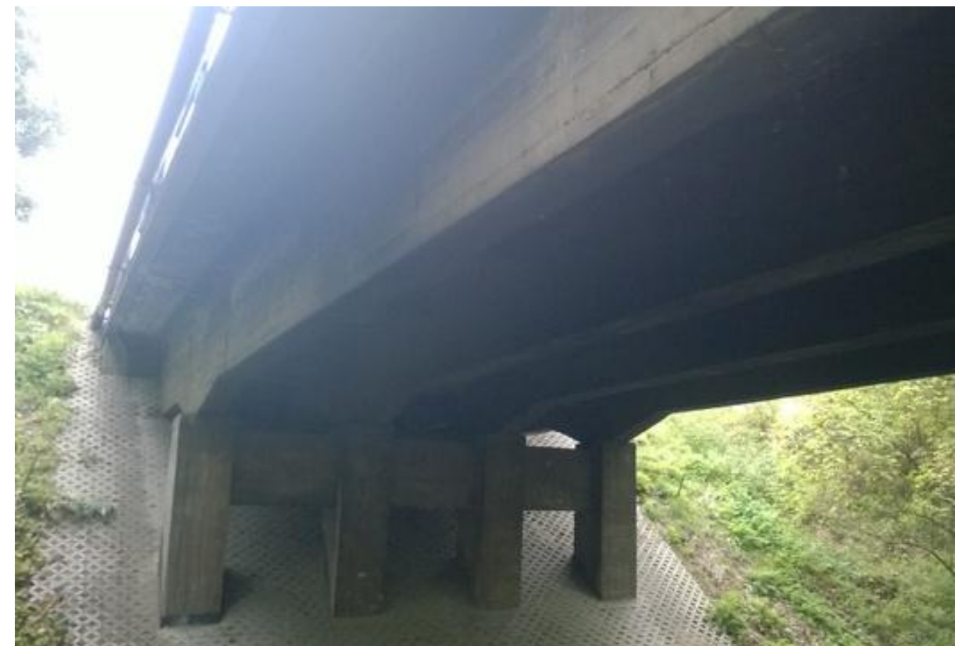
Fot. 4. Widok w kierunku Wodzisławia Śl. na filar i spód konstrukcji wiaduku
